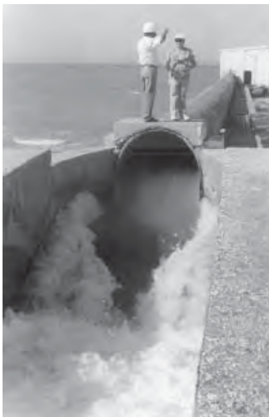
Foto 1. Estación de bombeo que extrae el agua de mar para llenar los depósitos.
