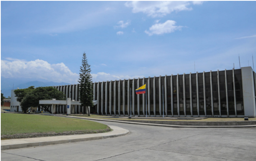
Fotografía de la fachada de la Fábrica de Moneda en Ibagué, Tolima
